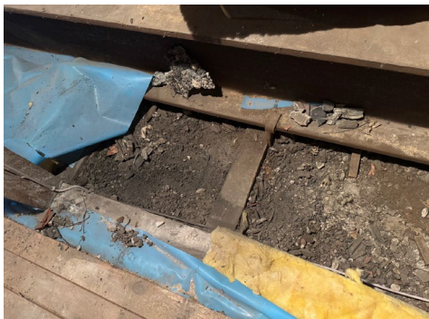
Schüttung Dachboden rechte Seite
